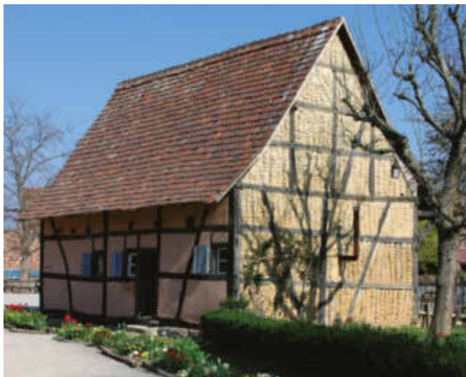
DANS CETTE MAISON RUSTIQUE LE TORCHIS EST FAÇONNÉ EN GAULETTES D'ARGILE, EMPILÉES LES UNES SUR LES AUTRES.
